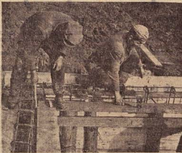
Na enem izmed Pionirjevih gradbišč
