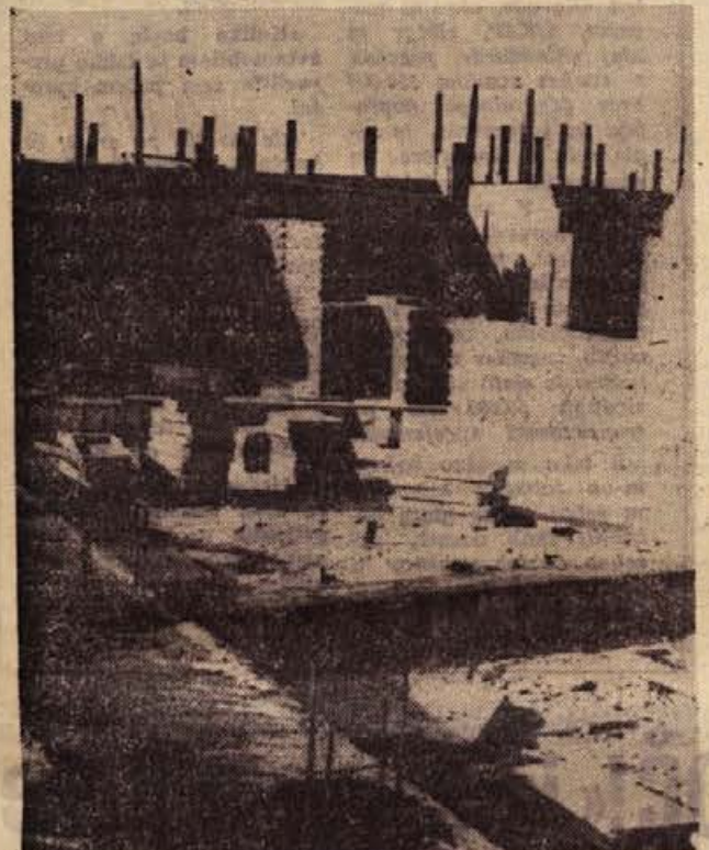
Tole so temelji in prvo zidovje nove šentjernejske šole. SGP PIONIR iz Novega mesta res hiti, da bodo vsa dela pravočasno končana in da bo dobil kraj dostojno šolsko poslopje, mladina pa svoj drugi dragi dom
