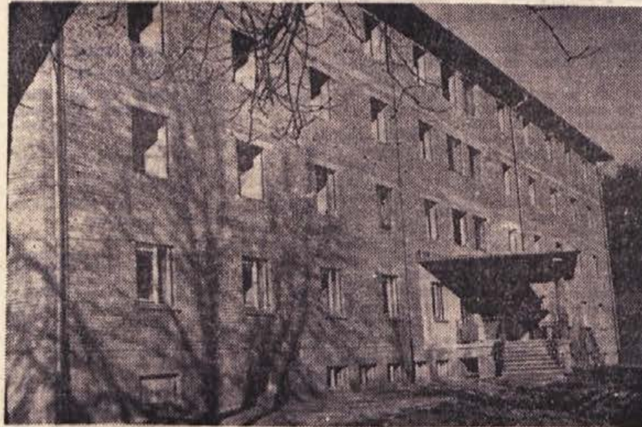
Samski dom SGP PIONIR v Novem mestu bo veljal 76 milijonov dinarjev. Kolektiv Pionirja, ki bo v stanovanja za svoje samske delavce vložil kar 45 milijonov dinarjev lastnih sredstev, bo s to gradnjo v precejšnji meri rešil pereč problem stanovanj za samce. V domu bo 220 ležišč, to pa je številka, ki nekaj pomeni! Ze 1. decembra bo v pritličju novega doma začela poslovati Pionirjeva obratna ambulanta. Oboje pomeni dragocen prispevek PIONIRJA za reševanje perečih družbenih potreb prebivalcev Novega mesta - Tudi delavci, tehniki, inženirji in uslužbenci kolektiva SGP PIONIR pozdravljajo DAN REPUBLIKE z novimi delovnimi uspehi in čestitajo za 29. NOVEMBER vsem kolektivom v republikli!
