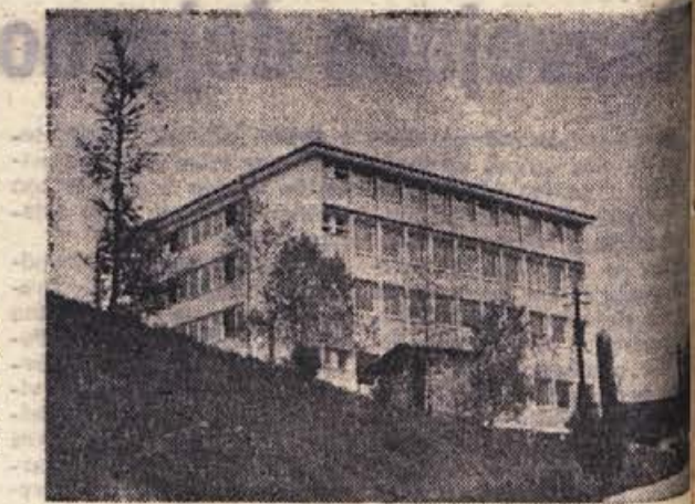
Novo poslopje Podjetja za PTT promet v Novem mestu je lepa arhitektonska pridobitev za mesto, predvsem pa pomeni kot sedež nove avtomatske telefonske centralne pomembno vozlišče vseh bodočih hitrejših zvez v okraju.
