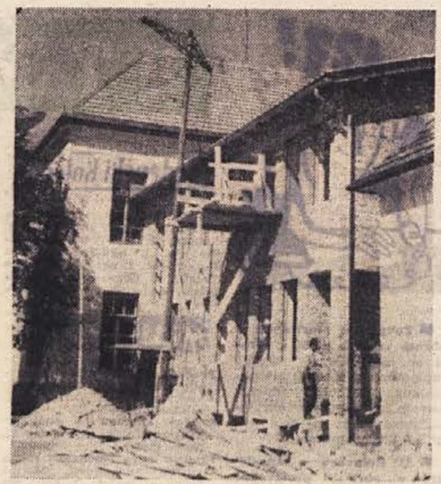
Pogled na del stavbe, ki bo povezal kirurški oddelk novomeške bolnišnice s stavbo nekdanje izolirnice. V novem delu bo dobila prostore ambulanta kirurškega oddelka, ki je bila doslej močno utesnjena, onkološka postaja, ki je doslej gostovala v kleti, v prvem nadstropju pa bodo uredili 20 ležišč za bolnike. Investicija bo veljala 30 milijonov, 1 ležišče pa 500 tisoč, kar je zelo malo, ker sicer stane 1 ležišče v bolnišnici 3 milijone do 3 milijone in pol dinarjev
