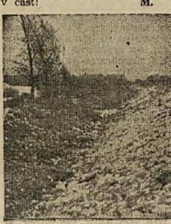
S-vski nasip, ki bo ščitil desni breg Save pri Čatežu in Čateških Toplicah pred poplavami
