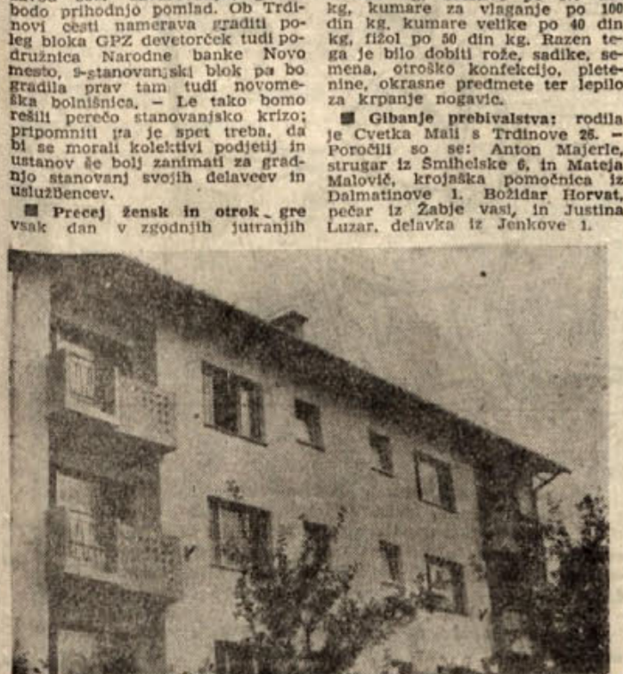
Nov 9-stanovanjski blok Gozdarske poslovne zveze ob Trdinovi cesti
