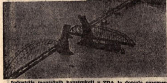
Industrija montažnih konstrukcij v ZDA je dosegla ogromen napredek, ki ga kaže tudi gornja slika: skozi dvinčni most, ki spaja Pennsylvania in New Jersey, pelje po reki Delaware poseben konvoj montažni železniški most, tezak 2465 ton. Most so potem postavili na postavljene temelje na isti reki.
