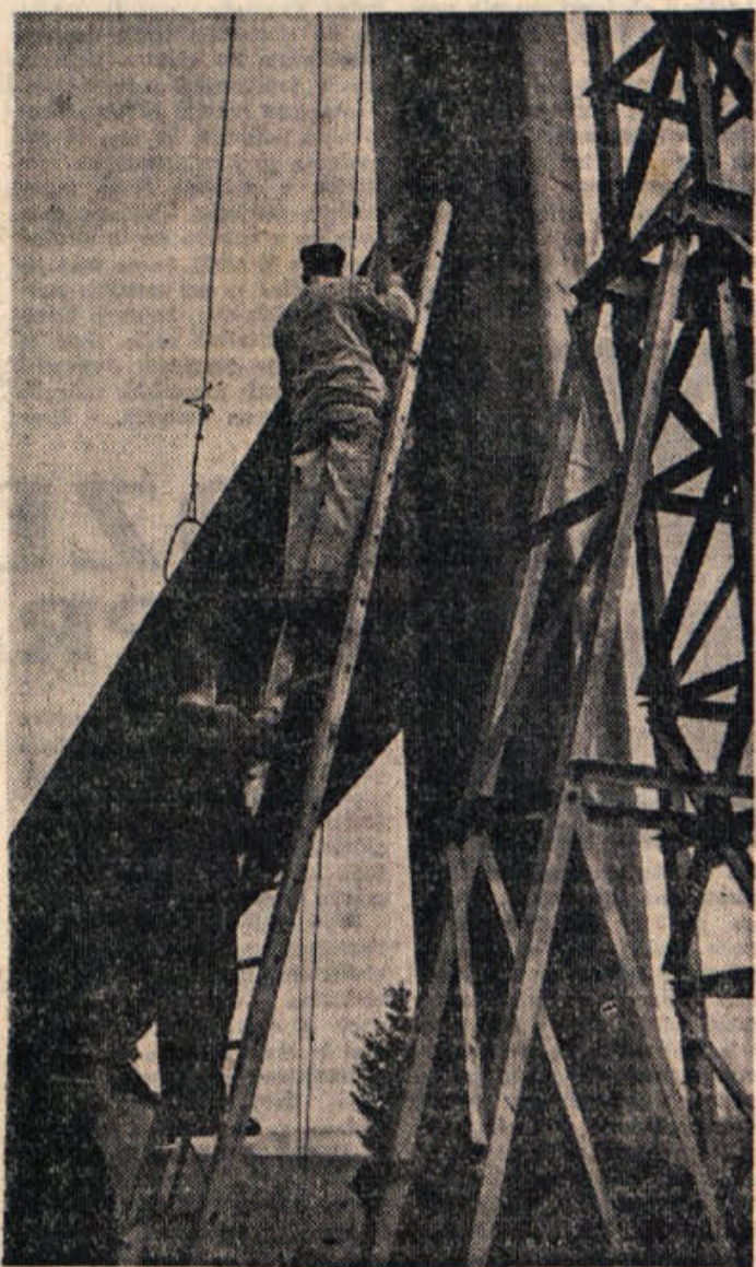
25 m visok dimnik pri kotlarni obrata vezanih plošč v Straži že stoji. Le še nekaj malenkosti bosta opravila varilca, ki ju vidite na sliki
