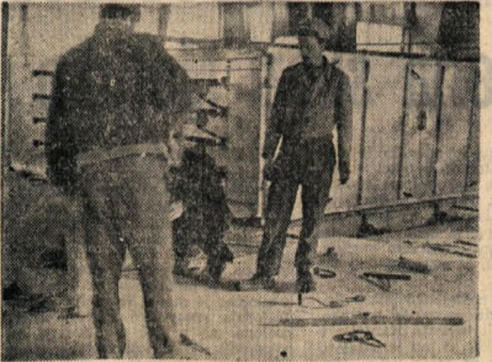
Koporčeva mizarska skupina sestavlja pokrov za parilno jamo. V ozadju del susilnice, ki so jo nemški strokovnjaki zaradi uspešne pomoči Novolesovih delavcev montirali v roku, ki je za polovico krajši od predvidenega
