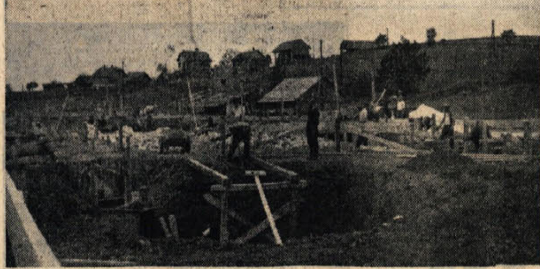
Še se uganili kaj je na sliki? To je gradbišče novega obrata za jedova kontrastna sredstva Tovarne zdravil Krka Novo mesto. Ko smo bili tukaj pred tremi tedni, je le sam buldozer planiral zemljo. Zdaj so že končali z izkopi za temelje, leseni opaži za betoniranje so pripravljeni. Stroji za mešanje betona hitijo na vso moč, saj je vreme ugodno. Prihodnje leto bo v novi tovarni že stekla proizvodnja.
