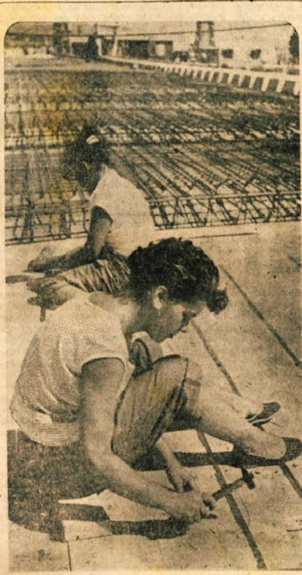
Takole so brigadirke pripravljale postelje nove avtomobilske ceste pred betoniranjem. Na dobro utrjen spodnji sloj cestnice se polagale papir, napi na pleteno železno mrežo. Še avgusta in septembra je bila takale podoba na Dolenjskem vsakdanji pojav...
