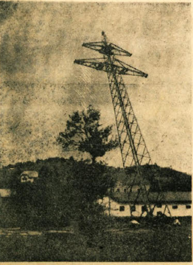
Daljnovod visoke napetosti postavljaajo s pomočjo posebnih vrvi
