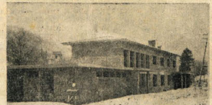
ZAKAJ SO ŠLI V ZEMLJO — sprašujejo mnogi ob pogledu na novo postajno postopje v Trebnjem. S tem modernim poslopjem so bili pri gradnji nekoliko preveč v zemljo. Tla v južnem delu stavbe so pod nižjavo železniškega tira, pri vhodni strani bo pa treba čisto zgraditi za kakih 60 cm. Za toliko bo potem večja strmina od postaje proti naselju.
