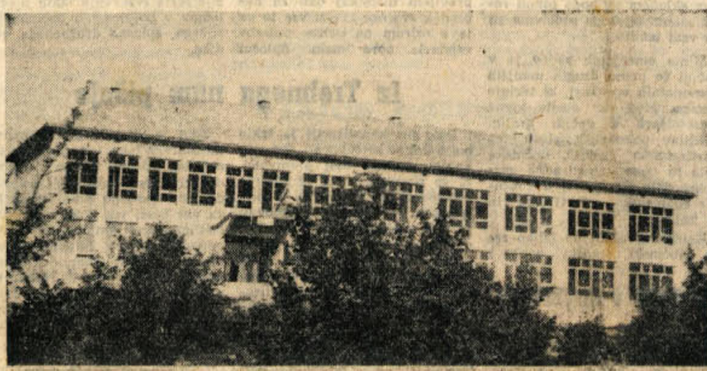
Pogled na novozgrajeno šolo v Prevolah (občina Zužemberk)
