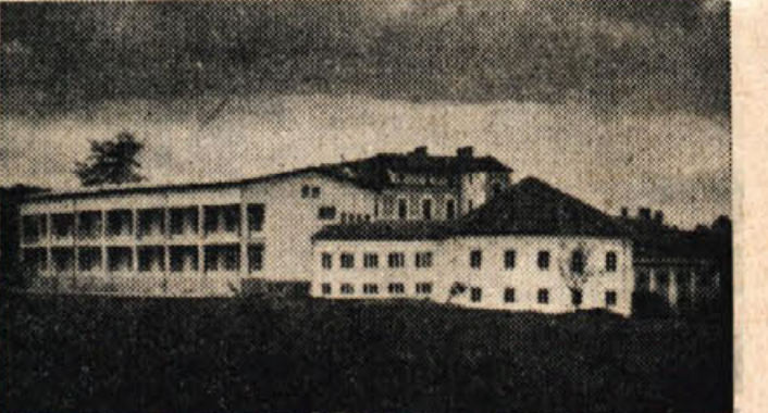
Pijučni oddelek novomeške bolnišnice, ki je po sedmih letih je zgrajen.
