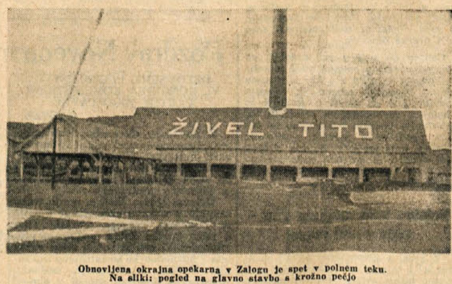
Obnovljena okrajna opekarna v Zalogu je spet v polnem teku. Na sliki: pogled na glavno stavbo s krožno pečjo
