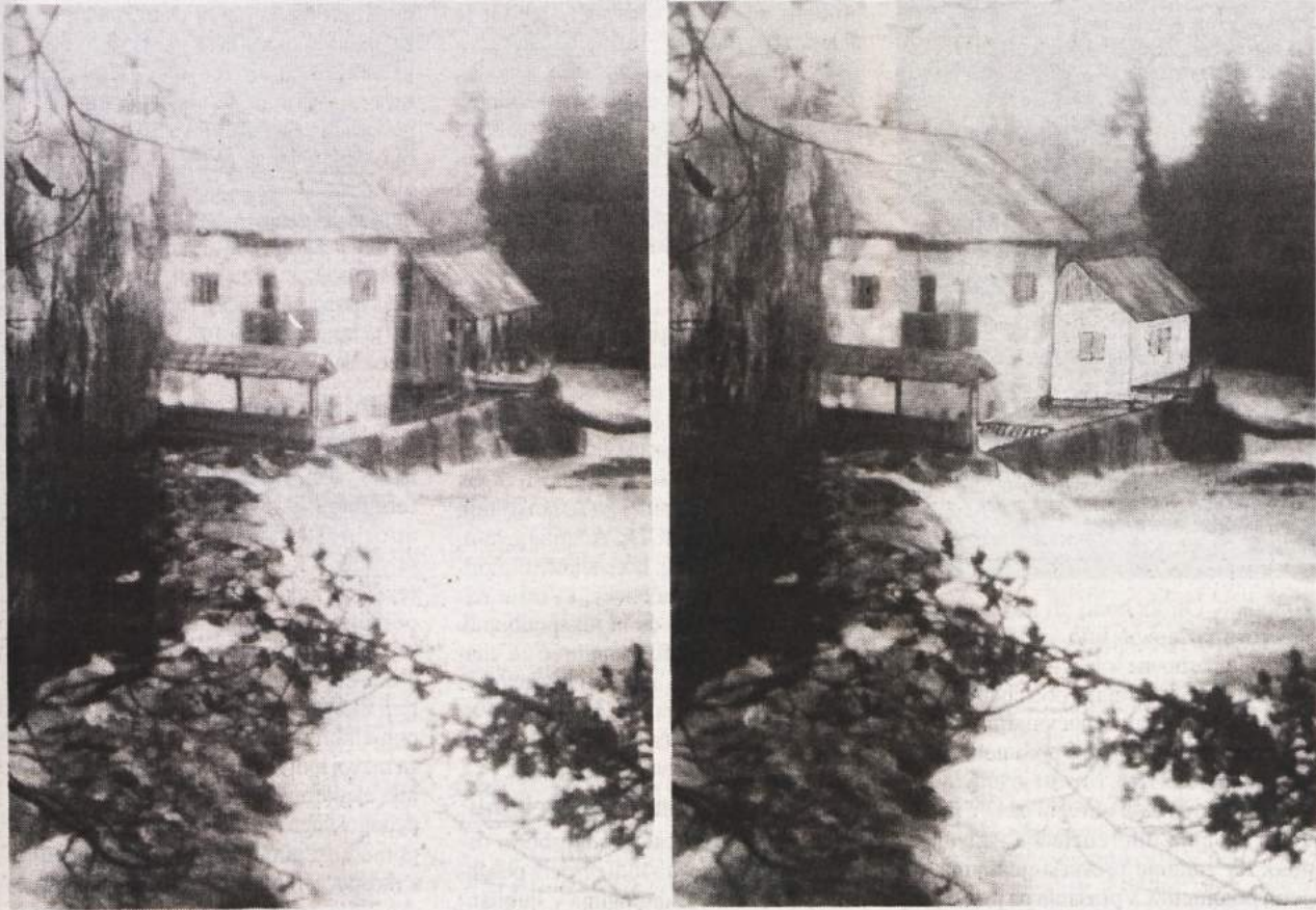
Slika mlina in žage v Marinči vasi št. 13 danes in slika istega mlina z vrisanim možnim celotnim objektom mHE, kjer je bruto padec 3.4 m pri skupnem srednjem letnem pretoku 11 m 3 /s
