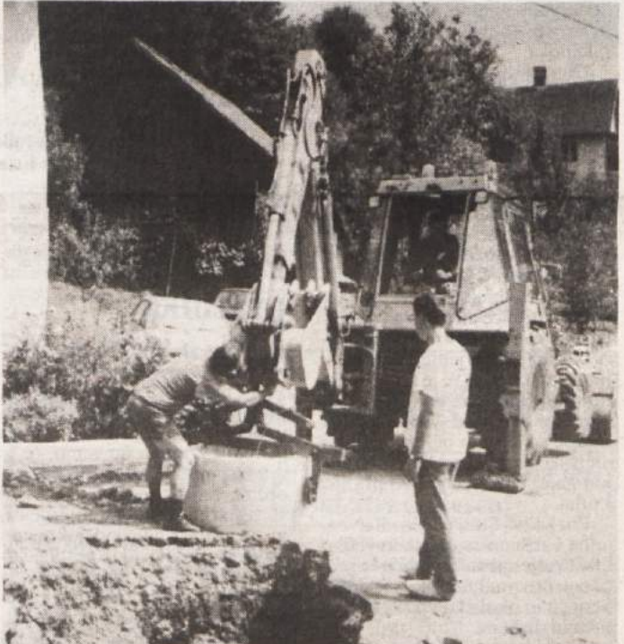
KANALIZACIJA IN ČISTILNA NAPRAVA - V Osilnici te dni dokončujejo prenovno čistilno napravo in gradnjo kanalizacije za Osilnico in Sela (na fotografiji). Sedanja čistilna naprava pri obratu LIV ni pravilno delovala in jo je bilo treba dograditi oz. popraviti, hkrati pa bodo nanjo priključili kanalizacijo iz omenjenih dveh vasi. (Foto: J. Primc)
