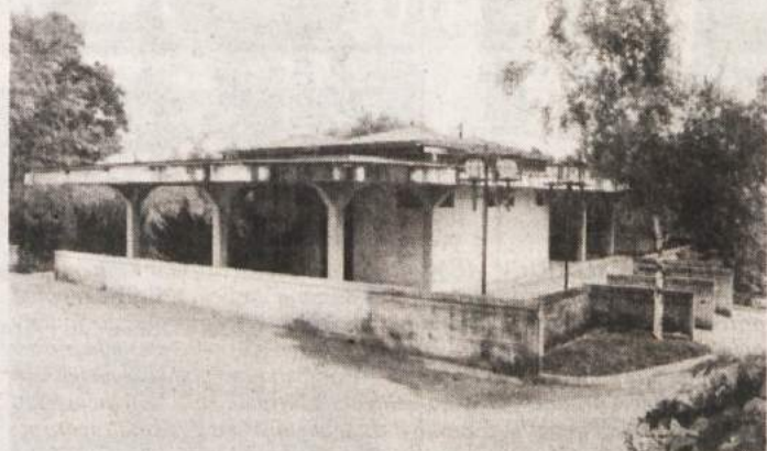
METLIŠKA VEŽICA - Mestna skupnost Metlika je začasno ustavila vse druge investicije, da bi čimprej adaptirali mrliško vežico. Da bi jo pokrili z novo streho, opremili priručno kuhinjo in sanitarije ter jo od zunaj s strani delno zasteklili, bo potrebno 10 milijonov tolarjev; kolikor približno znaša letni proračun mestne skupnosti. To je letos največja investicija metliške mestne skupnosti, delno pa bo priskočila na pomoč tudi občina. V mestni skupnosti so sicer že obravnavali druge prošnje za pomoč, vendar jih bodo dokončno rešili kasneje, medtem ko gre obnova šolske ulice že h koncu. Če za temeljito adaptacijo mrliške vežice ne bo dovolj denarja, jo bodo le prekrili. Izmed petih ponudnikov so za izvajalca izbrali podjetje Mercator Optima. (Foto: I. V.)
