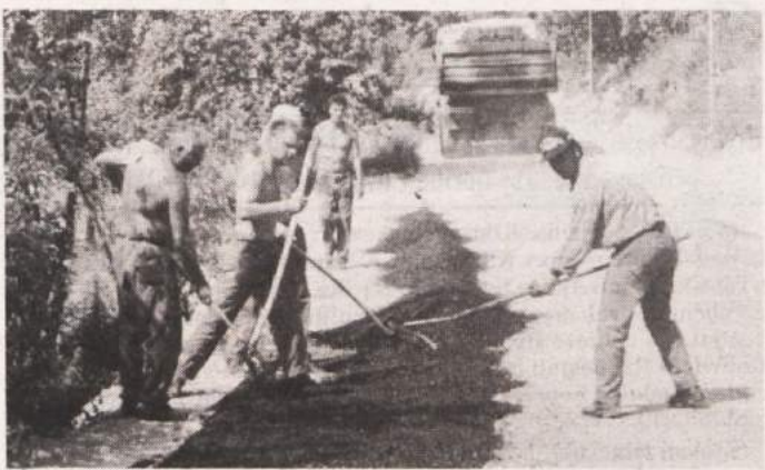
RAZŠIRITEV SUHORSKE CESTE - Zadnjo soboto so asfaltirali razširjeni del 1,5 km dolge ceste od odcepa ceste na Frato do konca vasi Suhor, za kar je vsak vaščan, vikendar ali lastnik zidanice prispeval po blizu 30 tisočakov. (Foto: A. B.)
