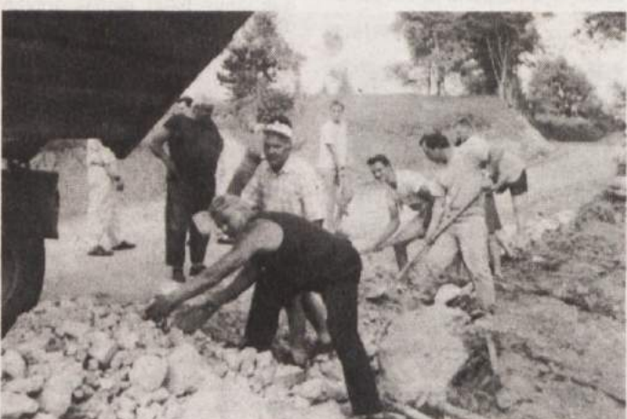
CESTA BO ŠIRŠA ZA METER DO METER IN POL - Vaščani so tako kot pred dvema letoma, ko so gradili kapelico, stopili skupaj in se odločili, da razširijo cesto, na kateri je vse več prometa. Upajo, da bo asfalt položen prihodnje leto.
