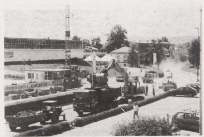
OBNOVLJENA KANDIJSKA CESTA - Preteklo soboto so zabrnili delovni stroji na Kandijski cesti v Novem mestu, ki je že vrsto let čakala obnove. Delavci Cestnega podjetja Novo mesto so s stroji odstranili zgornji ustroj ceste, ki bo z novo asfaltno prevleko mnogo prijaznejša. Granitne kokle, ki so do sedaj pokrivalo vozne površine, so povzročale prekomeren hrup, s prenovljeno Kandijsko cesto, ki je spadala med najbolj obremenjene mestne vpadnice, pa bo Novo mesto mnogo pridobilo. (Besedilo in fotografija: Bojan Avbar)
