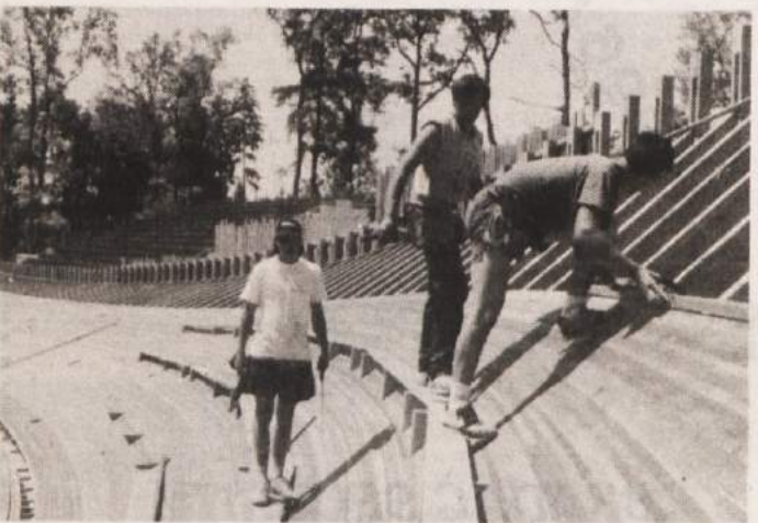
VELODROM KMALU NARED - Graditelji novomeškega kolesarskega dirkališča, na katerem se bodo avgusta najboljši mladi kolesarji z vsega sveta pomerili za naslove mladinskih svetovnih prvakov, bo kmalu nared, čeprav se graditelji otepaajo s težavami. Steza bi bila nared že junija, če ne bi morali čakati na še eno pošiljko dragocene afriškega lesa, saj ga jim je nekaj zmanjkalo, ko so morali zaradi slabe kakovosti izločiti kar precej letov. Kljub temu napovedujejo, da bodo prvi kolesarji zapeljali na 250 m dolgo in 7 m široko tekmovalno stezo že v začetku julija, ko naj bi dirkališče tudi homologirali, 15. julija pa bo na njem državno prvenstvo za člane in mladince, na trening pa so se že javili Angleži in Italijani. Na sliki so delavci pri polaganju parketa na delu steze, kjer je njen naklon večji od 44 stopinj. (Foto: I. V.)
