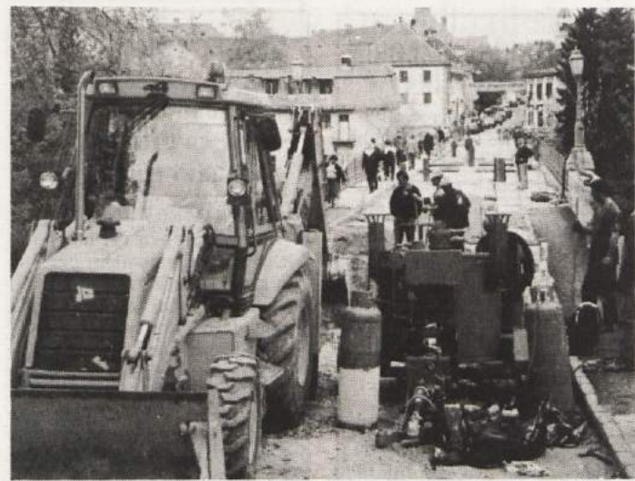
MOST BO KMALU ODPRT - Dela pri obnovi kandijskega mostu potekajo po načrtih in predvidevanjih in tako bo, zatrujejo, most odprt v tem mesecu. Promet po njem bo dovoljen za lažja vozila in bo potekal enosmerno. Ko bo stekel promet, bo seveda konec brezskrbnega pešačenja po mostu. Most in tudi celotno staro mestno jedro bi lahko, pravijo odgovorni, za promet povsem zaprli šele po izgradnji severne obvoznice. (Foto: A. B.)
