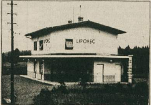
Postaja Lipovec, ki je bila zgrajena v času italijanske okupacije in po vojni obnovljena, ne služi več svojemu namenu
