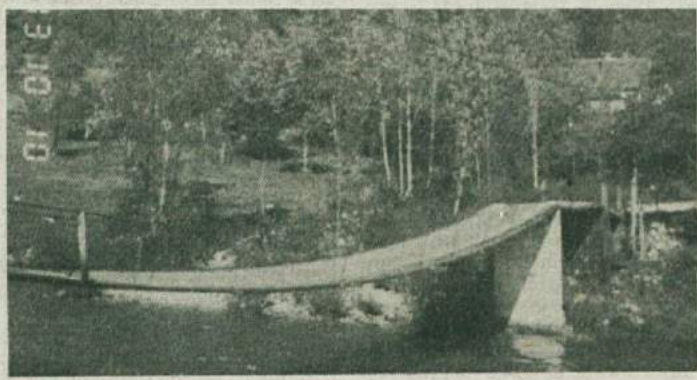
VČASIH SO SPAJALI, ZDAJ LOČUJEJO - Na fotografiji je viseči most prek Kolpe, ki povezuje vasi Turke (Hrvaška) in Grintovec (Slovenija). Od Osičnice do Slavskega Laza pri Fari so trije taki viseči mostovi, ki jih zdaj uradno ni moč uporabljati, ker tu ni uradnih meddržavnih omejenih prehodov. Razen tega je prek Kolpe in Čabranke še nekaj mostov, kjer zdaj tudi ni dovoljen prehod. Včasih so mostovi ljudi spajali, zdaj jih ločujejo. (Foto: J. Primc)
