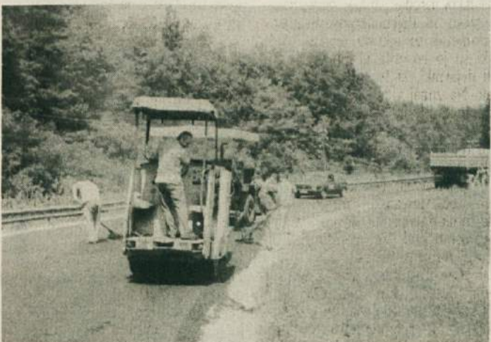
POSLEJ PO LEPSI CESTI DO MIRNE? - Konec prejšnjega tedna so delavci Cestnega podjetja popravljali enega najbolj dotrajanih delov ceste, ki pelje od Trebnja na Mimo, in sicer od prehoda z železniško progo za Sevnico proti vasi Dol pri Trebnjem. Ta del ceste so preplastili, popravila in preplastitve pa bi bil potreben tudi ostali del ceste. Tega bi bili najbolj veseli ljudje, ki se vsak dan vozijo po tej cesti, in tudi tamkajšnja podjetja, ki po njen privlačijo material in odvažajo svojo robo. (Foto: J. Dornič)
