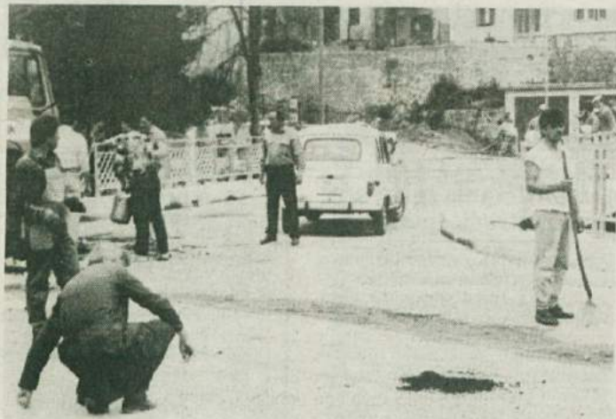
OBNOVLJENA MOSTOVA - Pred kratkim so obnovili hudo načeto cestišče na spodnjih dveh mostovih črnomaljskega tromostovja. Gre za mostova čez Dobljčico in Lahinjo ob sotočju teh rek. Delavci so se pri obnovi potrudili in delo hitro opravili, tako da ni bilo daljših in hušjih zastojev. Ob tem so obnovili tudi mostni ograji. (Foto: A. B.)
