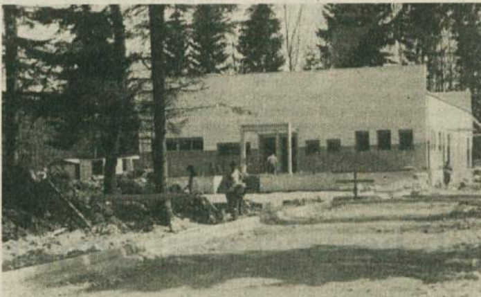
ZAPOSILITEV ZA 40 LJUDI - V novem tekstilnem obratu podjetja Feniks v Stari Cerki bo zaposlitev dobilo najmanj 40 ljudi. Na gradbišču so delali vsi zimo, ne glede na vremenske razmere, kljub temu pa se bo začetek proizvodnje, ki je bil načrtovan za okoli 1. maja, pomaknil nekoliko proti koncu tega meseca. (Foto: M. L.-S.)
