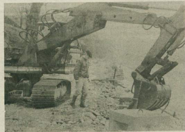
VAS ŠENTJUR NA POLJU NI VEČ OGRŌŽENA - Tako zagotavljajo delavci novomeške Vodnogospodarskega podjetja (VGP), ki so od novembra lani do zdaj vgradili že okrog 15.000 kubikov kamenja in sipine na več kot 450 m levega brega Save; 226 m brežine do hidroelektrarne Vrhuvo, ki je ob preusmeritvi toka reke Save povzročila spodjedanje brežine in ogrozila vas Šentjur, bo zavaroval celjski Nivo. Novomeščani so sprva načrtovali, da bodo dela končali do 1. maja, zdaj pa kaže, da bodo še okrog 7000 m 3 materiala vgradili dva tedna prej. Vodja vodnogospodarskega sektorja pri VGP, inž. Stane Pavlin, je te dni poudaril, da so že delali strokovno bolj zahtevne projekte, da pa je po jakosti zavarovanje pred Savo tod največje. Naložba bo veljala 46 milijonov tolarjev. (Foto: P. Perc)
