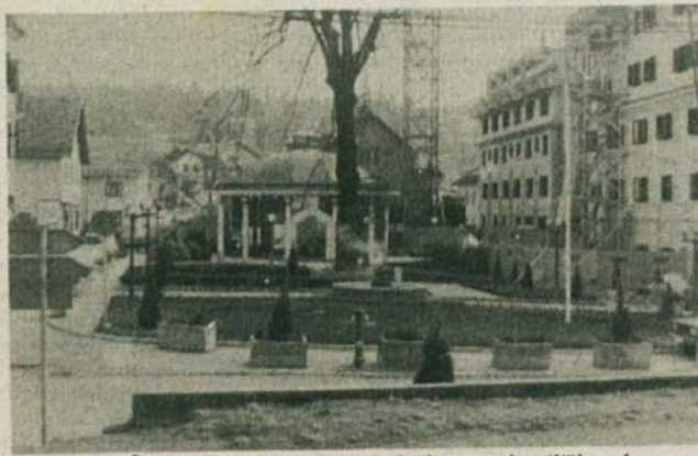
ZDRAVILIŠKI TRG — Z izgradnjo objekta za zdraviliško zdravstvo bo trg v Dolenjskih Toplicah zaokrožil svojo podobo. Obenem ga bodo zaprli za promet, za kar bo treba na drugem delu zgraditi most. (Foto: A. B.)
