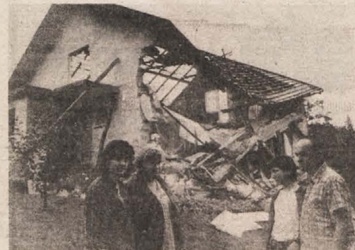
OSTALI ŽIVI — Tone in Slavka Mikolavčič ter njuni hčerki 14-letna Darja in 12-letna Nataša ne bodo mogli izbristati iz spomina eksplozije plina v nedeljskem jutru, 6. aprila ob 5.25. Ne samo zato, ker so ostali brez doma, ampak ker v hudi nesreči nihče ni bil niti poškodovan. Pogled na napol porušeno hišo ne daje takih možnosti. (Foto: P. Perc)
