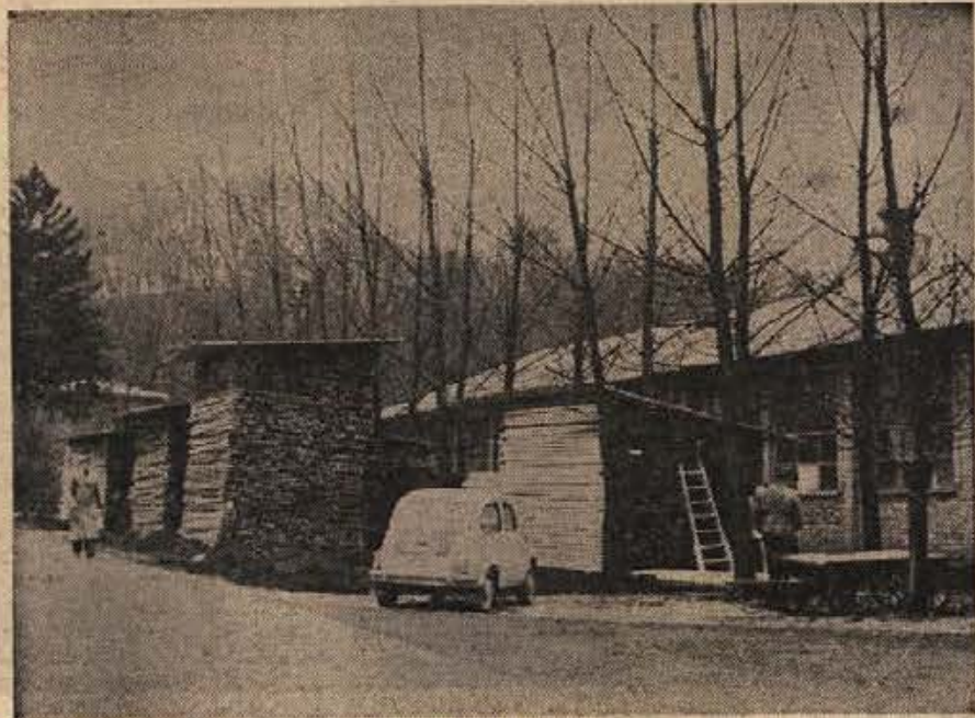
Obrat Splošnega mizarstva v Krškem, ki so ga prizadevni člani kolektiva pomagali zgraditi s prostovoljnim delom. (Foto: J. Teppey)
