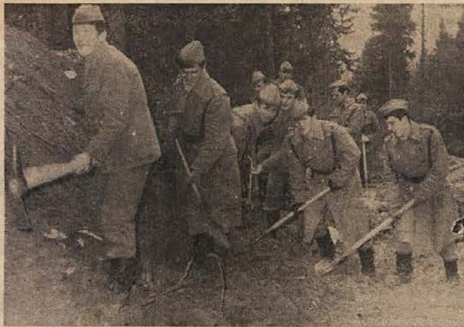
Vojaki novomeške garnizije (na siki) so zadnje dni decembra razširjali cesto od Bučne vasi do gostilne Pugetj pod Trško goro. Cesta, ki jo bodo dokončno uredili do prihodnje jeseni, bo omogočila prevoz šolskim otrokom v novo bršlinsko šolo in turistično bolj odprla Trško goro. (Foto: S. Dokl)
