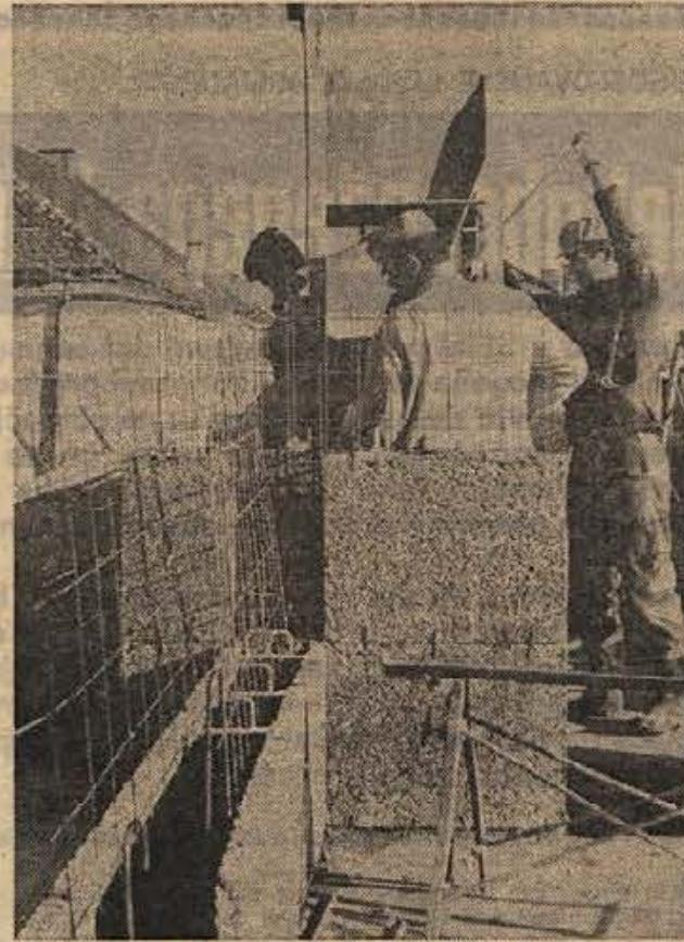
GRADNJA, KJER OPAZI OSTANEJO. Tako nastajajo novi bloki v Trebnjem. Delavci vsipišajo beton med veloks plošče, ki so najprej opaži, kasneje pa izolacija. (Foto: Legan)
