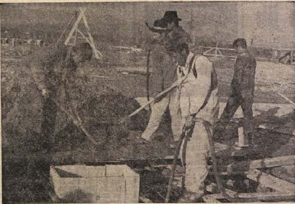
Na gradbišču za tovarno industrijske opreme IMV v Brežicah je že nekaj tednov zelo živo. Nova hala bo obsegala 4000 kvadratnih metrov površine. Temelje za kovinsko konstrukcijo betonirajo delavci podjetja Pionir. (Foto: J. Teppey)
