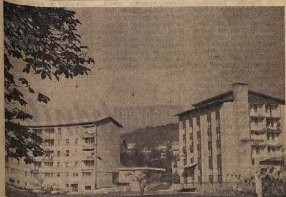
Novi del Krškega na levem bregu Save. Po vojni je zraslo tam veliko stanovanj- skih blokov. Precejšen delež je v stanovanjsko izgradnjo vložila tovarna papirja v Krškem, ki s krajevno skupnostjo skrbi tudi za to, da so ulice asfaltirane in da bo okolje v prihodnje še bolj urejeno (Foto: Jožica Teppey)
