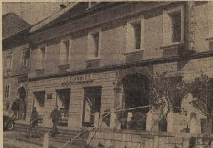
Naša upravna stavba na Glavnem trgu v Novem mestu. S preureditvijo smo v zgornjem nadstropju pridobili upravne prostore, v pritličju pa sodobno trgovino.
