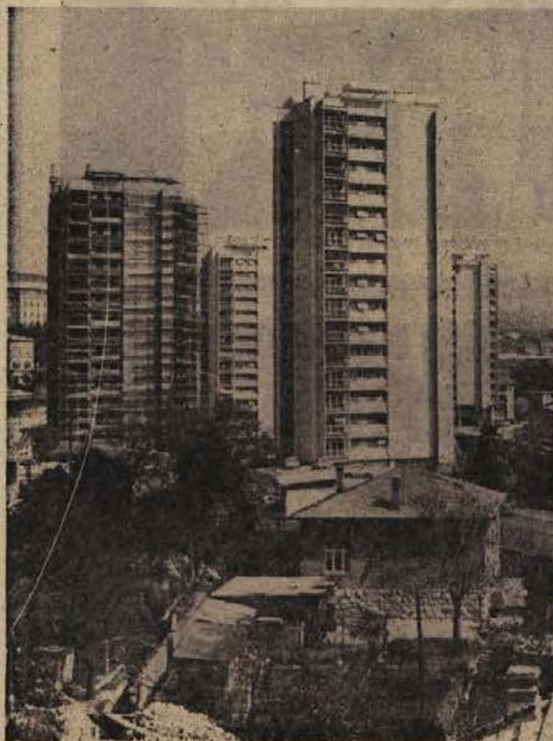
Novo stanovanjske stolpnice na Reki, ki jih je SGP PIONIR gradilo lani in letos
