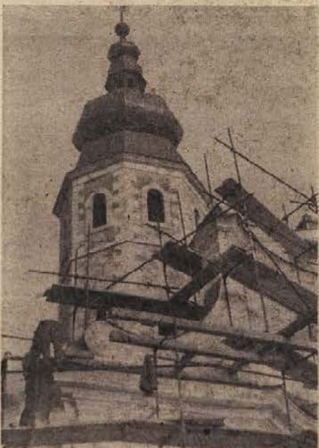
Portal pred samostansko cerkvijo v Kostanjevici prekrivajo te dni z bakreno pločevino. Delo opravljajo domači kleparji iz obrtnega podjetja Kleparstvo. Tudi kupolo na zvoniku so sami oblikovali z bakrom. (Foto: J. Teppey)
