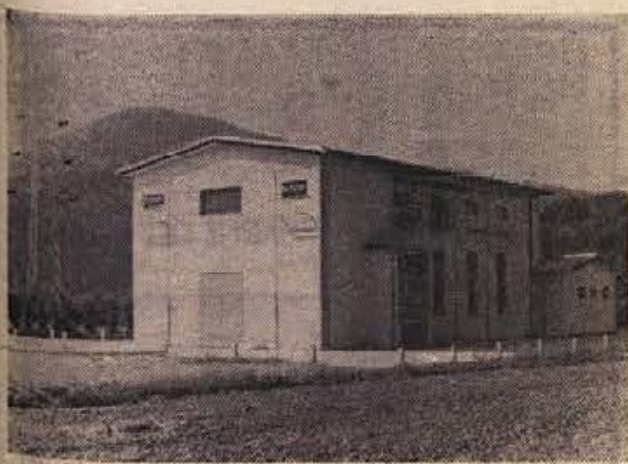
Pred kratkim je v Boštanju pričela obratovati nova razdelilna postaja. Zgradilo jo je Elektro Celje, enota Krško. S tem se bo možnost izpada električne energije na sevniškem območju precej zmanjšala. Foto: Franc Pavkovič
