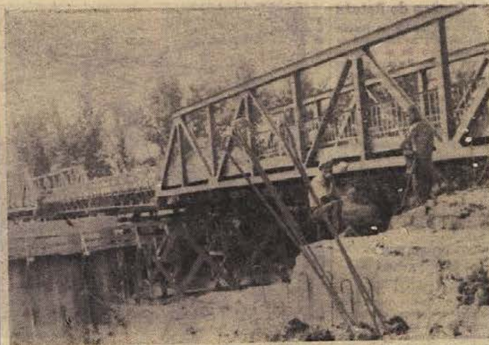
Poslovna enota za nizke gradnje iz Maribora, ki je enota ljubljanskega Gradisa, bo do dneva republike, če bo vse po sreči, končala nov most v Metliki. Čez Kolpo vozijo zdaj po zasilnem mostu, delavci pa že postavljajo betonske nosilce v vodi (Foto: Splichal).
