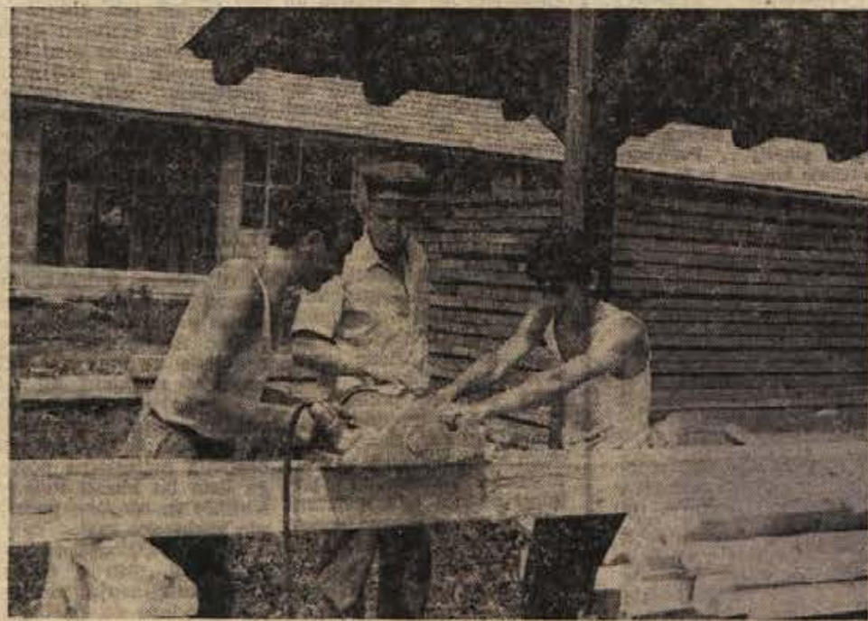
Vajenca poklicne tesarske šole uporabljata pod nadzorstvom inštruktorja električni skobelnik. V poklicni šoli se vajenci priučujejo delu z najsodobnejšimi delovnimi pripravami in na najsodobnejše načine.
