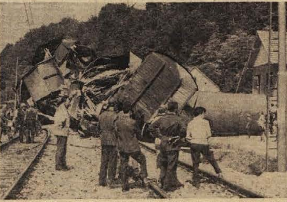
V četrtke, 25. junija ob 3.42, sta pri postaji Breistanica trčila tovorni vlak št. 452 in brzovlak München-Beograd. Medtem ko je bilo nekaj ljudi laže poškodovanih, pa je materialna škoda velika. En tovorni vagon je vrhlo na cesto Sevnica-Breistanica in je bil zaradi tega tudi promet na tej cesti onemogočen. (Foto: M. Vesel)
