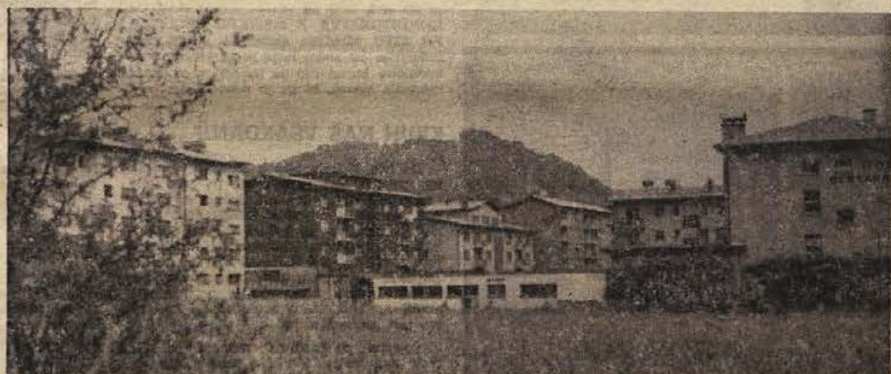
Tovarna »Djuro Salaja« daje veliko denarja svojim delavcem za individualno gradnjo, v načrtu pa ima tudi gradnjo več blokov. Veliko stanovanj so doslej že zgradili (na sliki).
