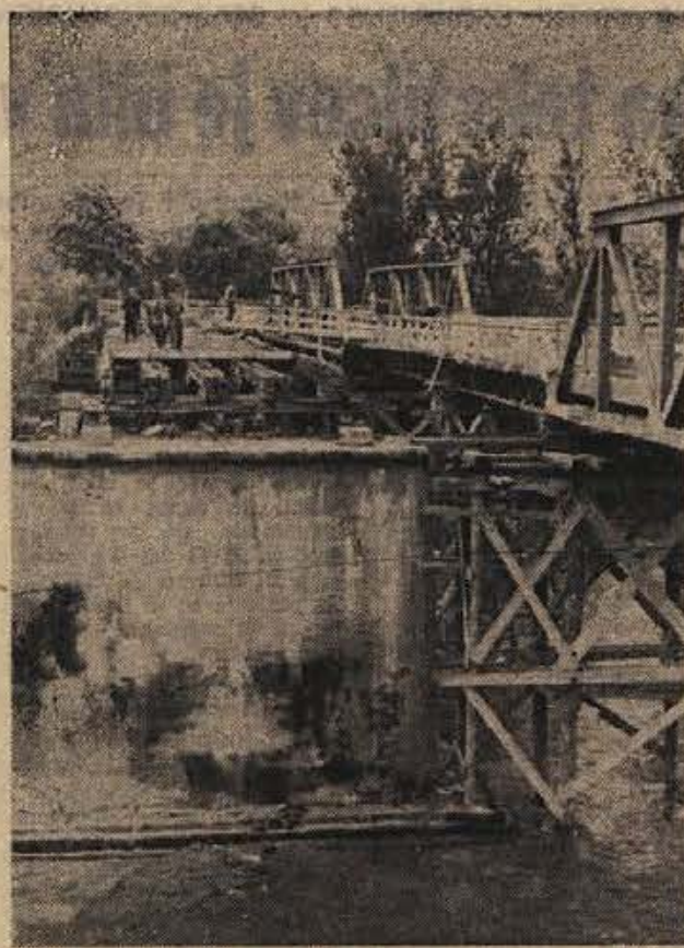
Dva mosta v Metliki! Na starih temeljih gradi podjetje Tehnogradnja nov most, ki bo širok 10,9 m. Da bi šli lahko pešci in vozovi do 2 toni še na Hrvaško in obratno, so stari del mosta dvignili in ga na vozčkih prepeljali 10 m vstran. (Foto: Ria Bačar)
