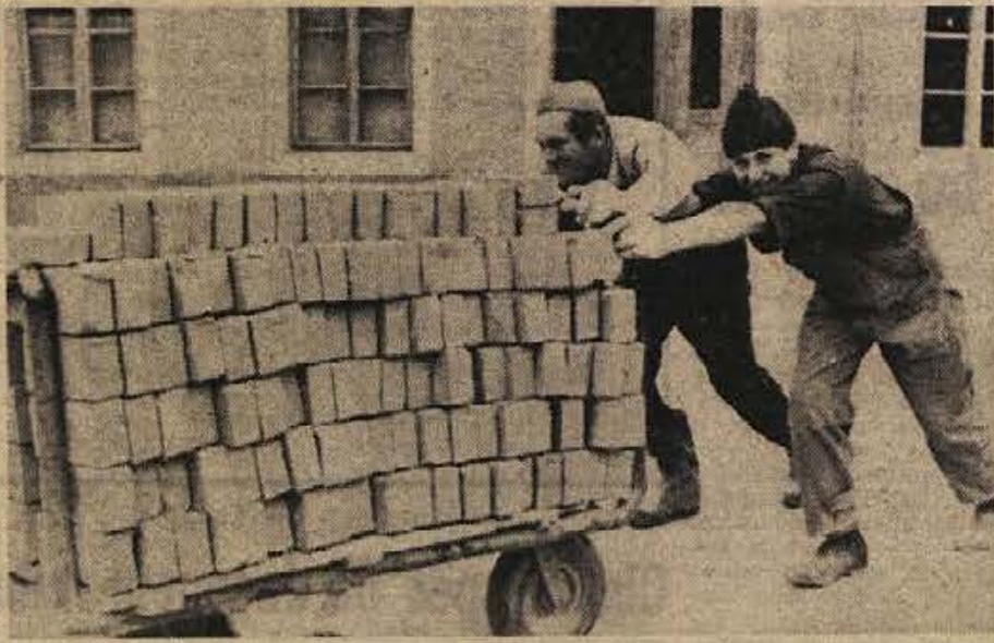
Anton Primc in Jože Franko se morata kar precej spottiti, da zrineta s surovo opeko naložen voziček do lope ali kozolca za sušenje. Po prenovitvi takega naravnega sušenja ne bo več. Opeko bodo sušili v veliki tunelski umetni sušilnici, kozolce in lope pa porušili
