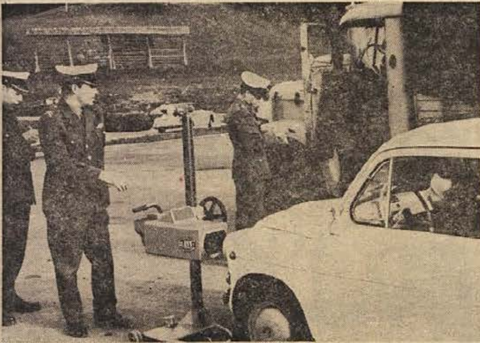
Regloskopa — naprave za kontrolo avtomobilskih žarometov, se ne da ogoljufati. Natančno pove, ali nesejo vaše luči nizko ali visoko. (Foto: Ivan Zoran)
