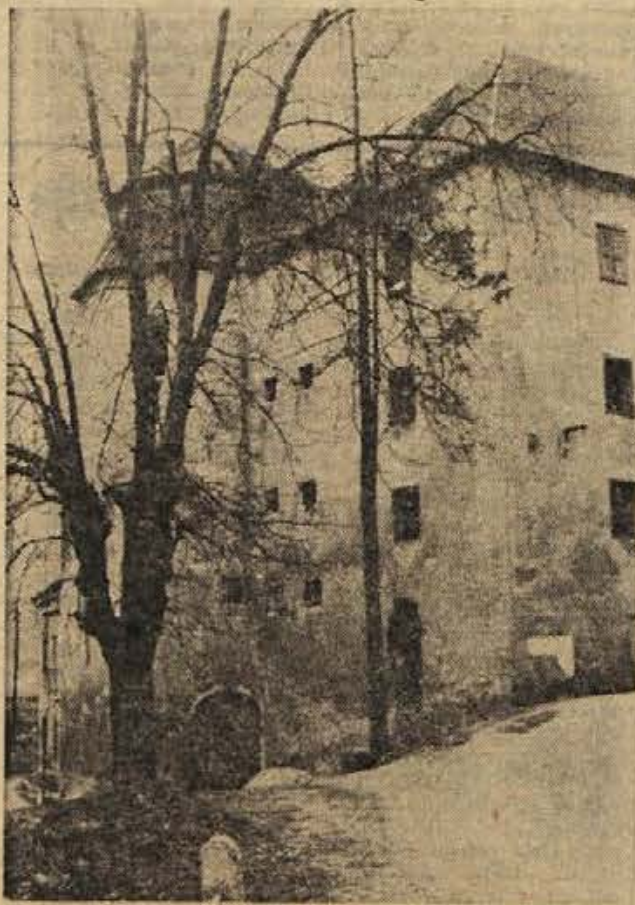
Razpadajoča graščina ob železniški progi v Brestanici marsikoga zbode v oči. Kaže, da je nekdanja mogočna zgradba dokončno obsojena na propad.
