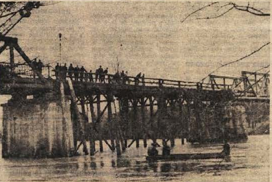
Začetna dela na gradnji metliškega mostu močno ovira narasla Kolpa, vseeno pa izvajalec del, podjetje Tehnogradnja iz Maribora, uspešno kljubuje deroči reki. (Foto: R. Bačer)
