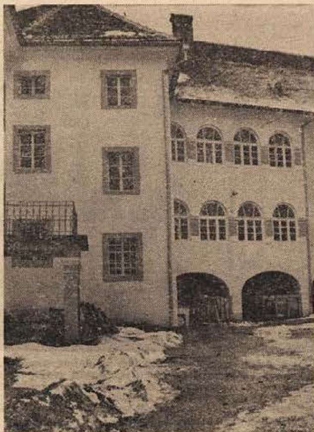
Metliški dom počitka je veliko pridobil z novo fasado na vhodni strani stavbe ter z drugimi preureditvenimi deli v notranjosti poslopja. Vse investicije so veljale okoli 90.000 din. (Foto: R. Bačer)
