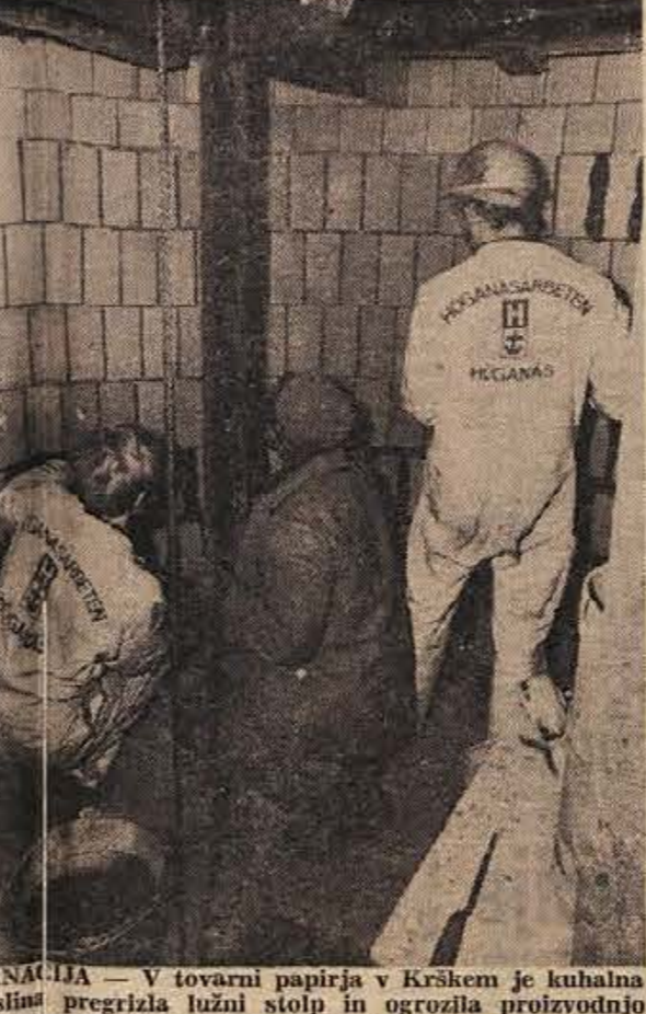
SANACIJA — V tovarni papirja v Krškem je kuhalna kislina pregrizala lužni stolp in ogrozila proizvodnjo celuloze. Strokovnjaki iz Švedske so stene obložili s posebnim opeko, ki je odporna proti kislini. Stolp bodo kmalu spet napolnili z apnenecem in spustili skozenj žveplom dioksid. (Foto: Tone Zalokar)
