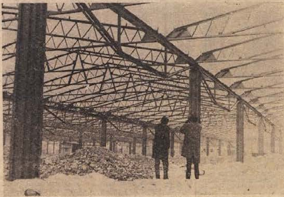
NAIVEČJA TE VRSTE V SLOVENIJI. Doslej največji proizvodni uspeh Kemoopreme iz Trebnjega: v 120 dneh je bilo narejeno in postavljeno montažno kovinsko ogrodje za okoli 16.000 kvadratnih metrov veliko industrijsko dvorano tovarne Alples v Železnikih pri Škofji Loki. Pri izdelavi so uporabljali točkasto varjenje hladne pločevine. Novi način omogoča za dobro tretjino cenejšo gradnjo in še enkrat krajši čas izdelave. (Foto: M. Legan)
